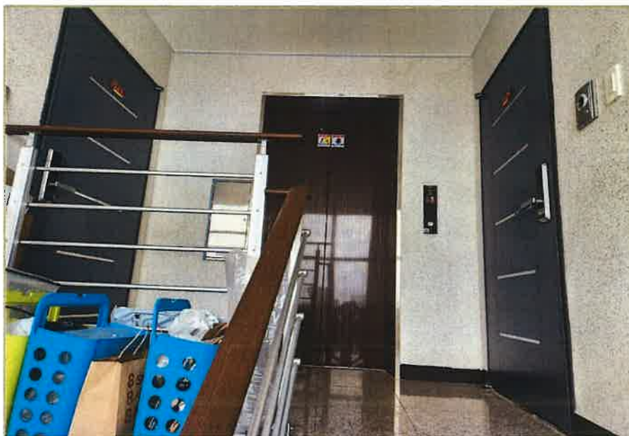
본건 건물 4층
